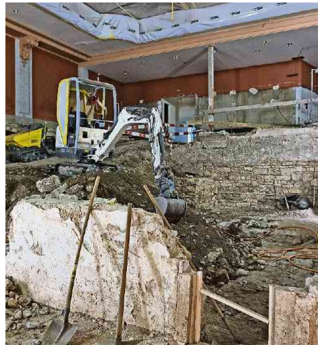
Sieben Meter in einem Jahr: Um im engen Zeitplan zu bleiben, wird auch schweres Gerät eingesetzt.
