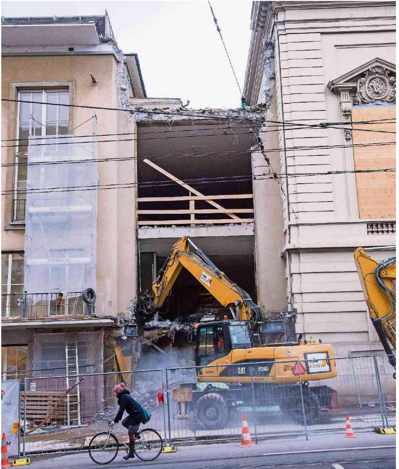
Casino-Abriss Das Stadtcasino erhält derzeit sein neues Gesicht. Damit dieses entstehen kann, muss als Erstes der Zwischenteil den Weg frei machen. FOTO: NICOLE NARS-ZIMMER
